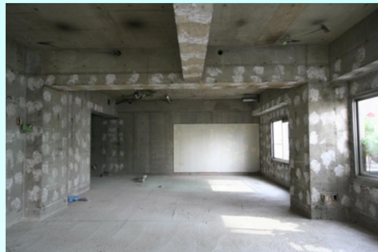
無断熱の躯体
