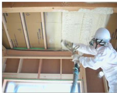
アクアフォーム施工事例
