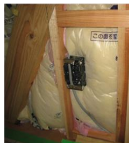
グラスウール施工事例
