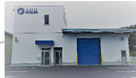
新潟営業所 2019年9月竣工
