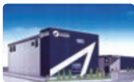
厚木営業所 2020年3月竣工予定
