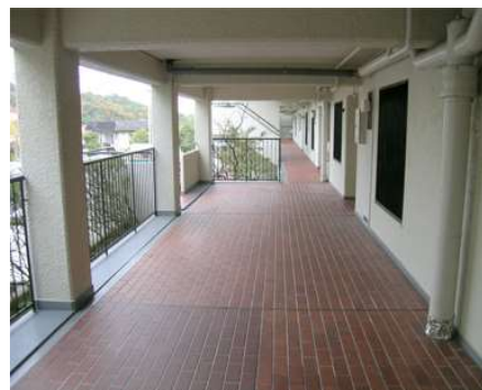
共用廊下防水
