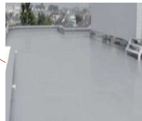
マンション屋上防水
