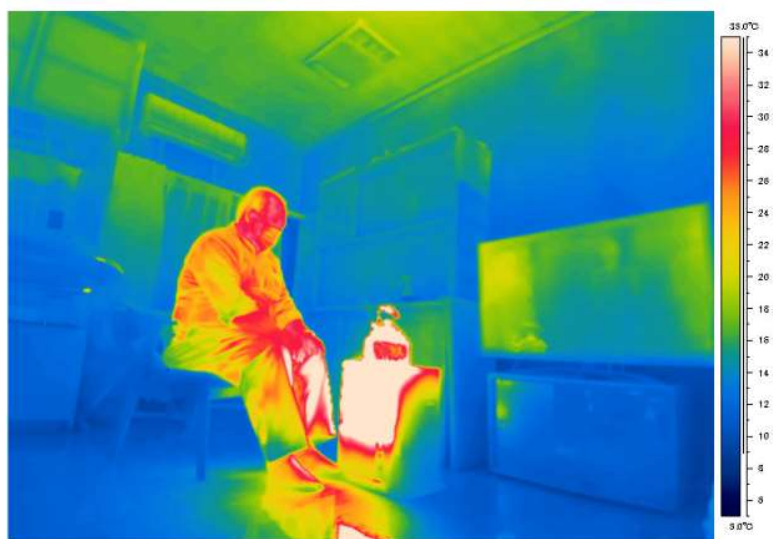
断熱+気密改修前
