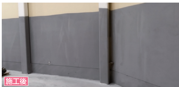
[施工面積26.6m 2 、調合時間 1回10分、吹付時間22分]
