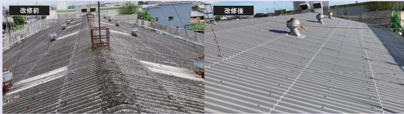
穴があいたストレート屋根の改修
