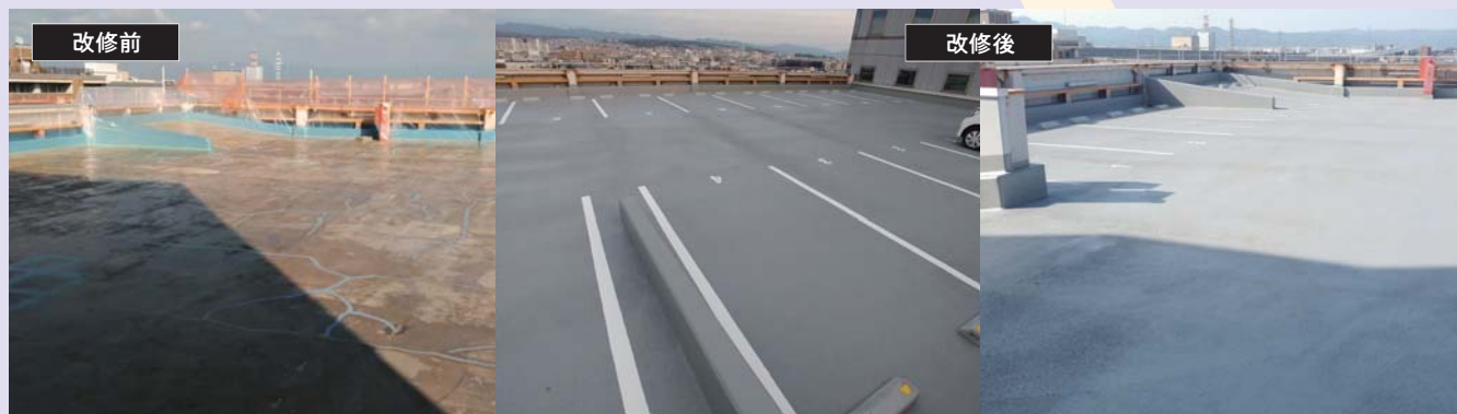
立体駐車場スロープ
