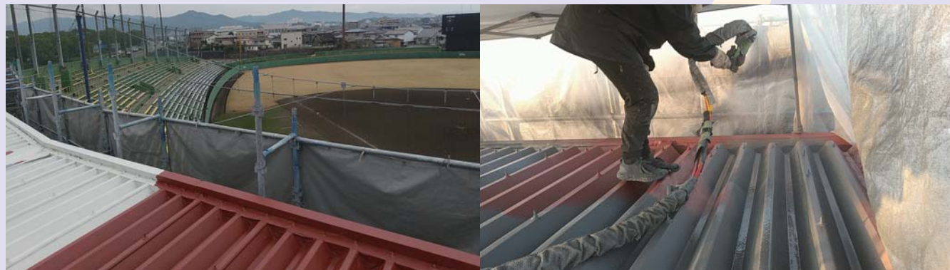
折板屋根 改修
