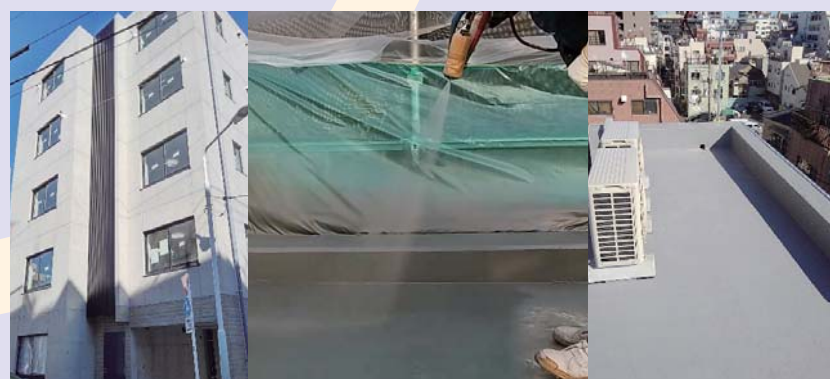
マンション屋上
