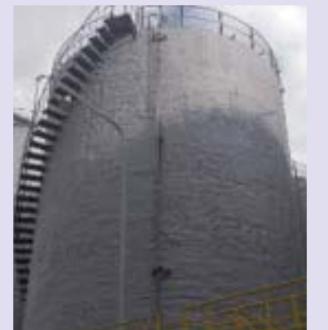
屋外タンク断熱・防露・防水
