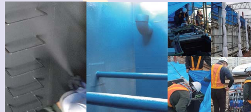
JR車両洗浄タンク修繕工事
