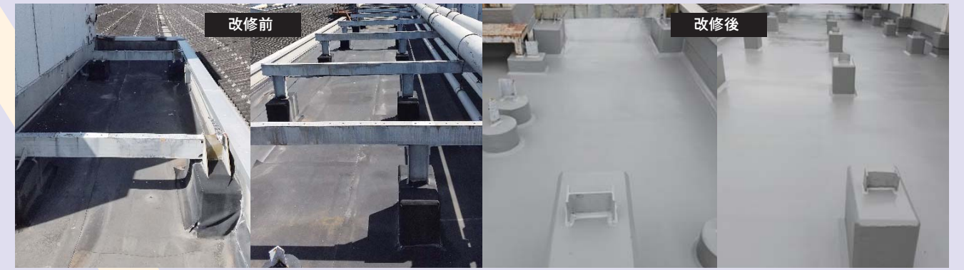
鉄道駅舎屋上
