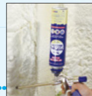
細かい隙間へ注入
