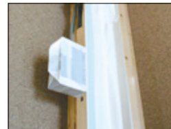
養生作業(コンセント周り)
