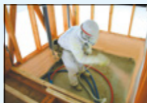
基礎部立上り
